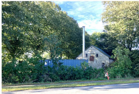
Den midlertidige fjernvarmecentral ud mod Amtsvejen.
