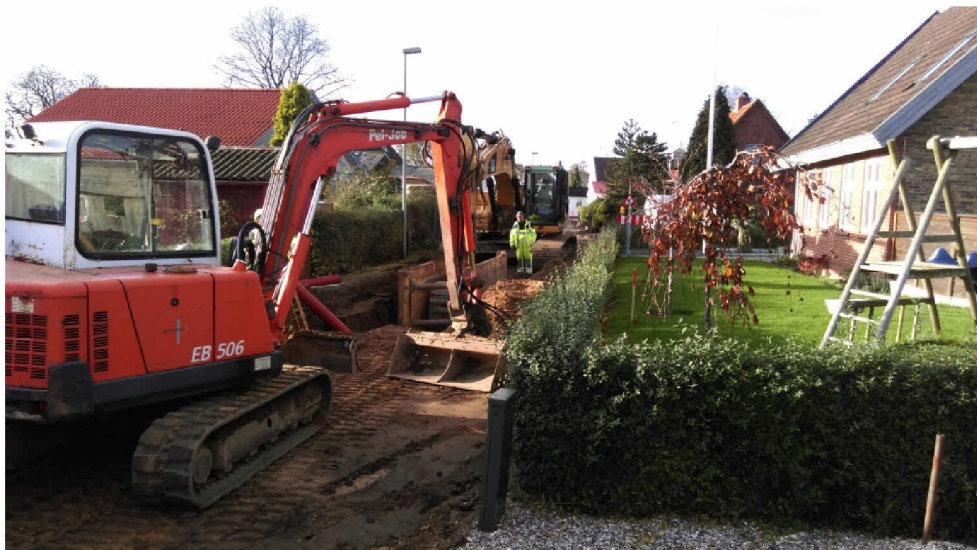
Foto: Gravearbejde foran Tingvej 9
